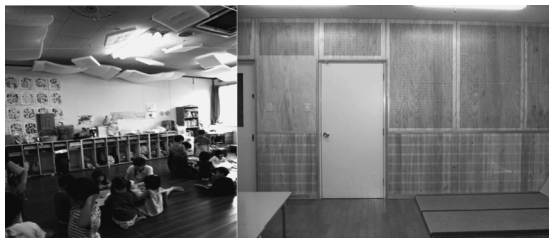
図-2 保育園での吸音実験と県産材吸音板の施工
