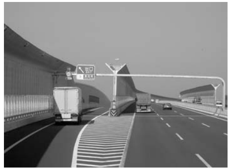
実際に設置された大型の分岐型遮音壁。H鋼を隠し、見える部分を滑らかにした。
